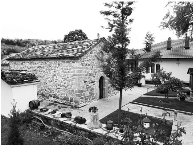
Obnovený chrám v monastieri Zočište
